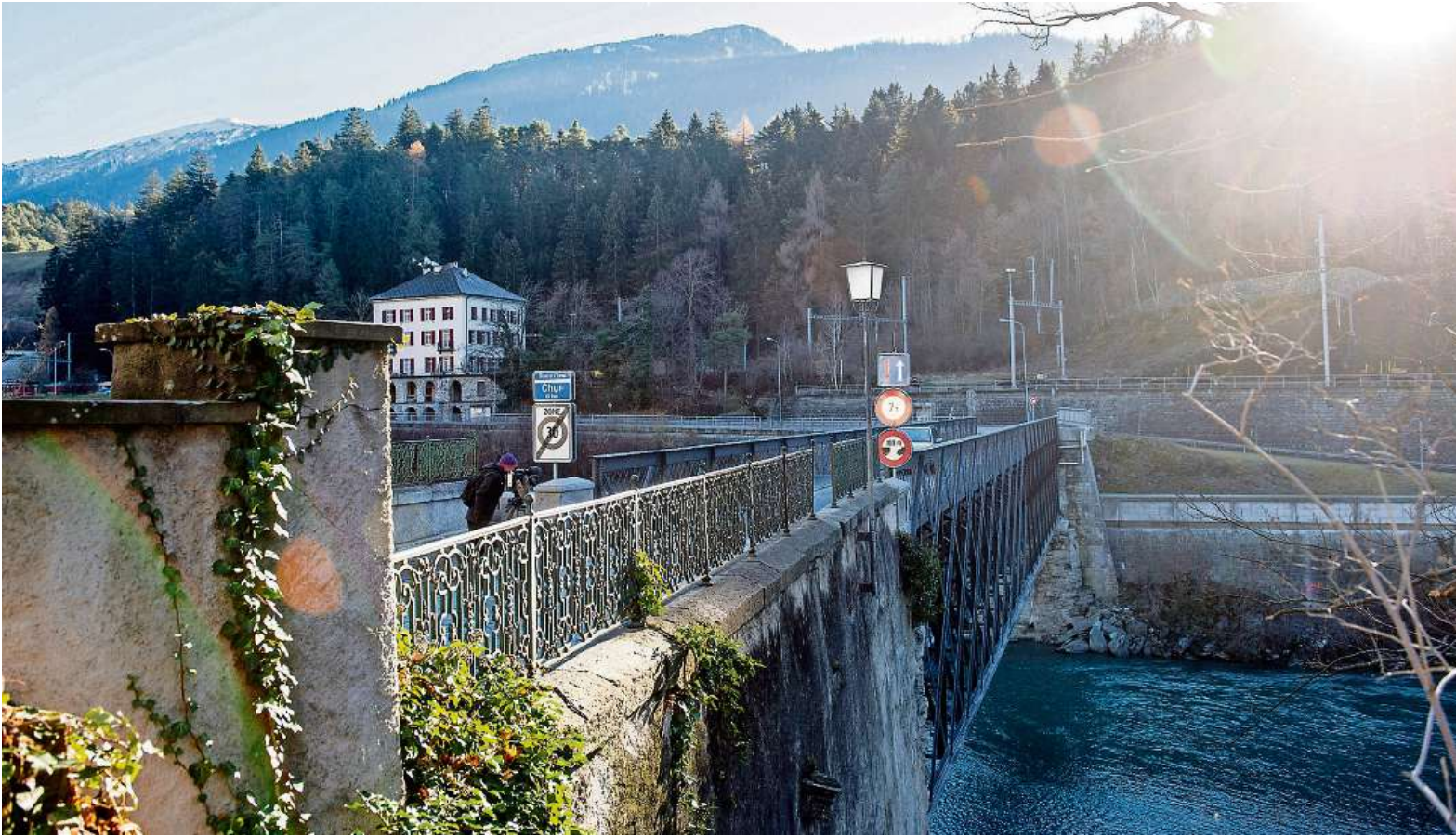
Die Rheinbrücke Reichenau wurde von Korrosionsschäden befreit und für die nächsten 30 bis 40 Jahre fit gemacht. (FOTO MARCO HARTMANN)
